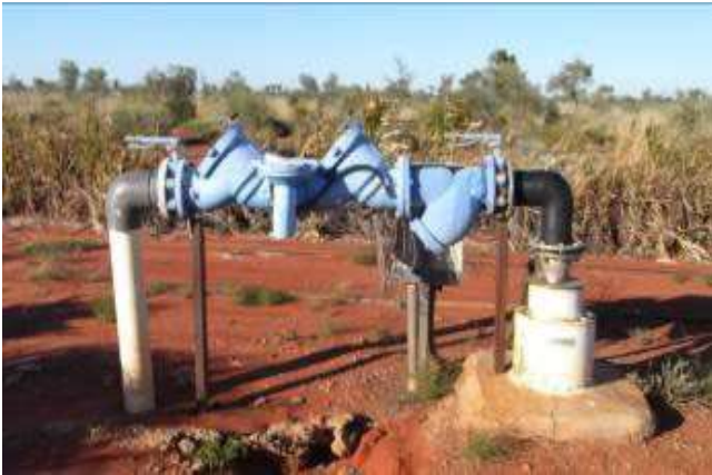
圖片 1 – RPZD設備，感謝北領地政府環境、公園和水資源安全部（DEPWS）提供圖片
