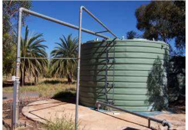
圖片 2 – 儲水箱氣隙設備，感謝北領地政府環境、公園和水資源安全部（DEPWS）提供圖片
