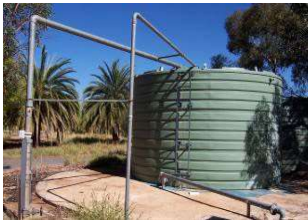
图片 2 – 储水箱气隙设备，感谢北领地政府环境、公园和水资源安全部（DEPWS）提供图片
